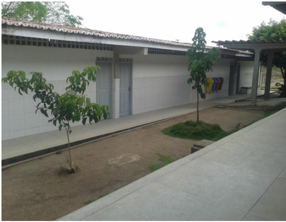
Primeiro bloco com 4 salas de aula Fonte: Arquivos da Autora
