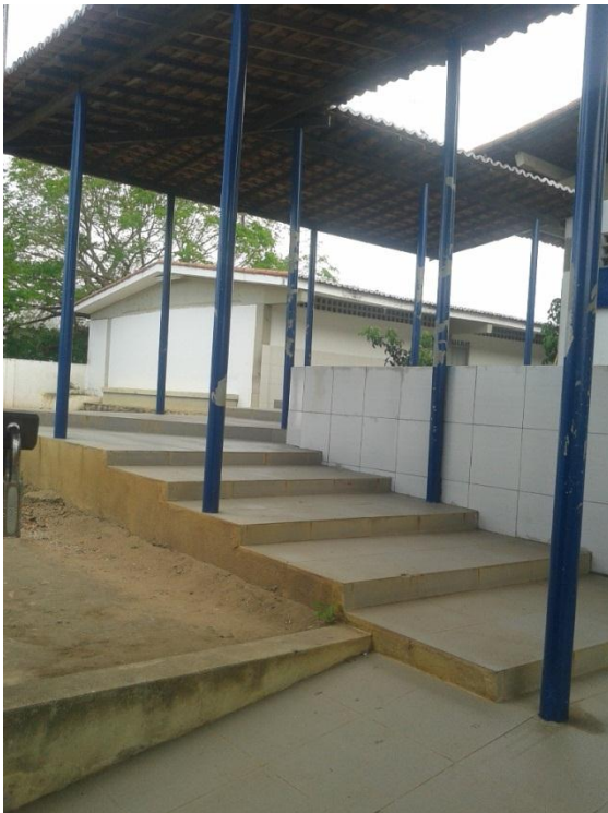
Escada na entrada da escola Fonte: Arquivos da Autora
