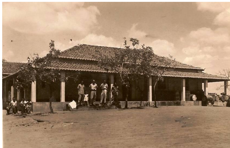
Foto 5. Escritório do DNOCS construído em Pilões no ano de 1922
