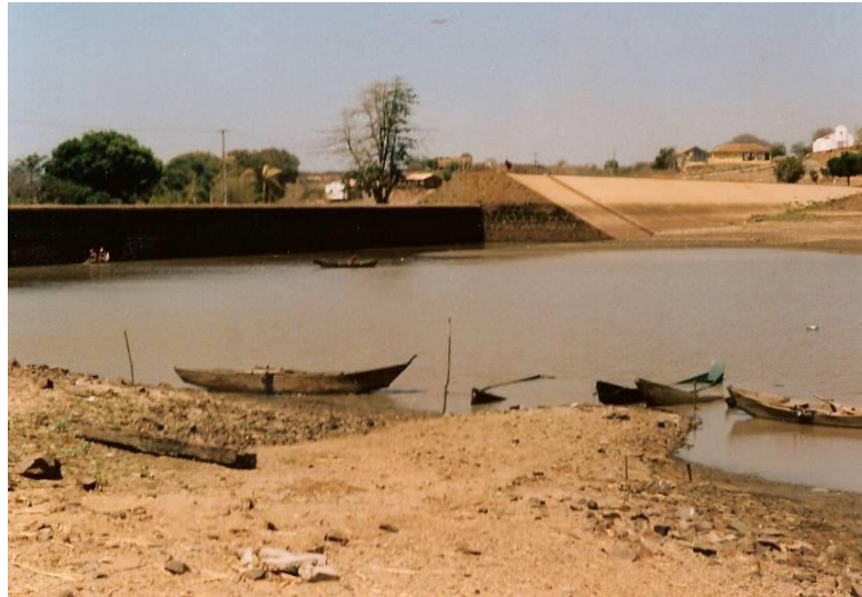
Foto 2. Pilões em situação crítica durante longos períodos de estiagem na década de 70.
