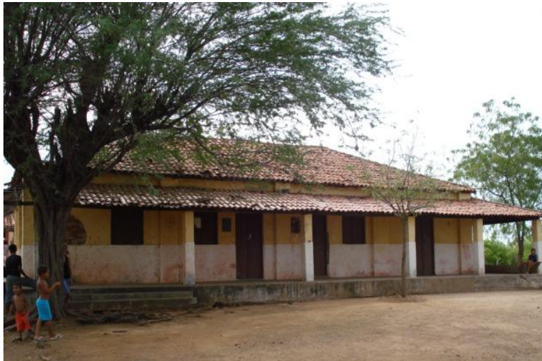
Foto 7. Prédio onde funcionava o escritório do DNOCS
