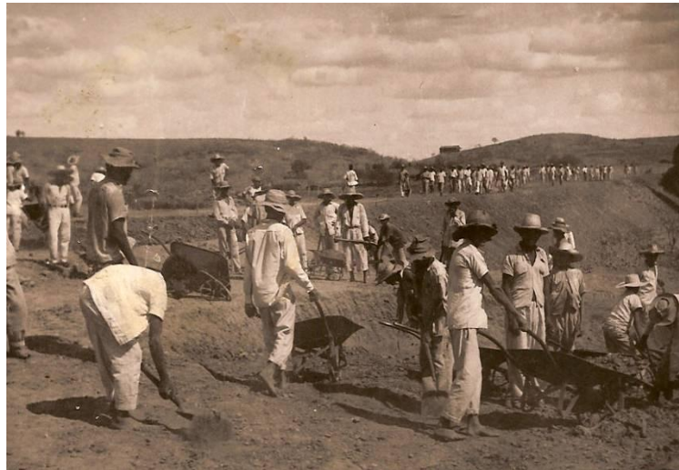
Foto 4. Pilões – aspecto da construção do açude situado à jusante da barragem “PILÕES”
