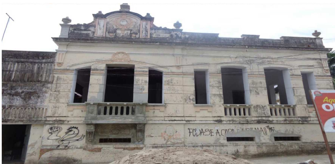
Figura 08 – Fachada frontal da edificação objeto do estudo.
