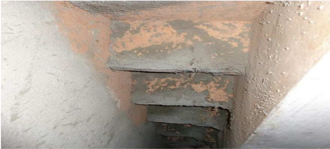
Figura 10: Escada no início do processo de restauração.
