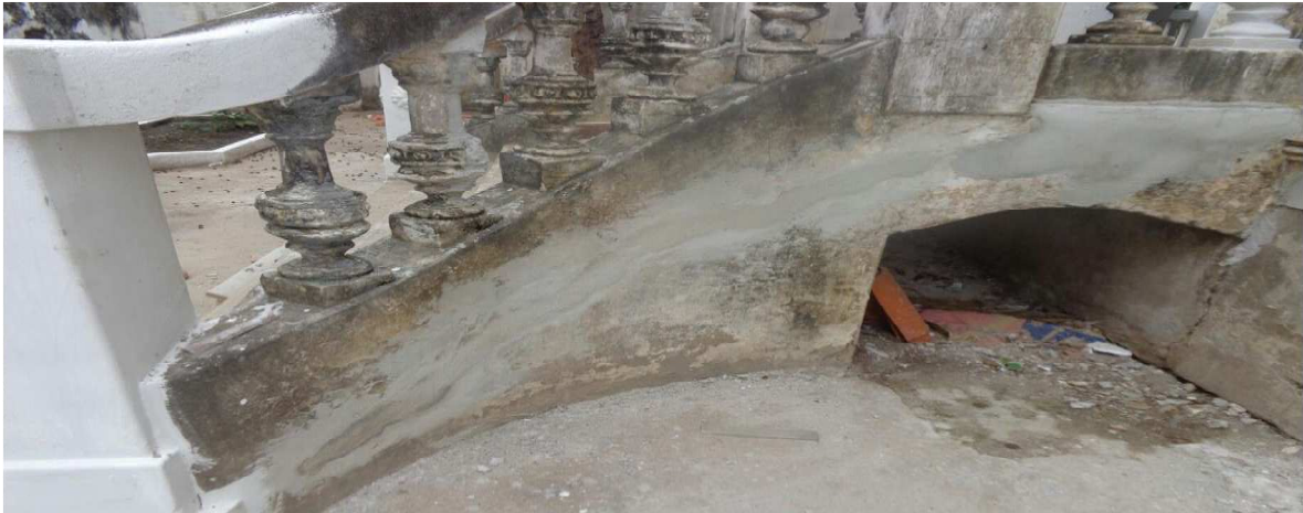
Figura 16: Reparo da lateral da escada.
