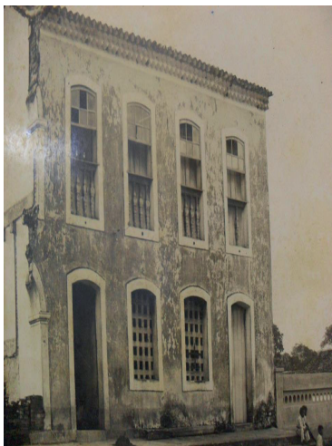
Imagem 1: Casa de Câmara e Cadeia - PILAR
