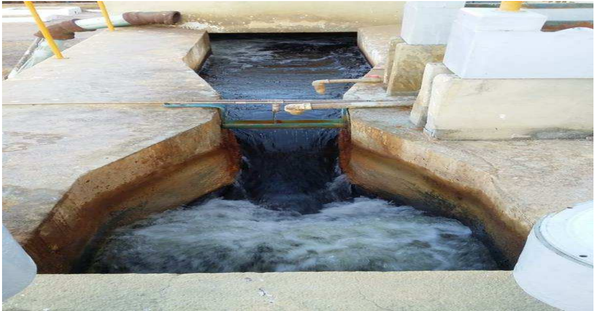
Figura 8: Misturador rápido tipo Calha Parshall
