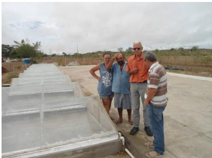
Trocamos duas vezes a espessuras das lâminas de alumínio e seu Ednaldo responsável pelo lote sugeriu que fizéssemos o isolamento das lâminas de alumínio por lona plástica por causa do alto teor de sal na água.
