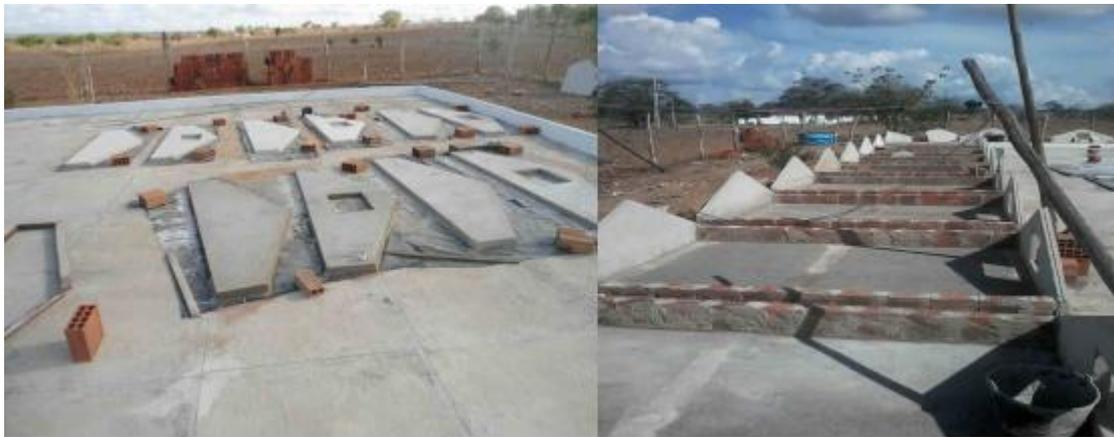
Figura 6: Dessalinizadores em construção sobre o calçada utilizando-se blocos pré-moldados.
