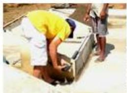
12ª Passo: Preparação do pré-moldado frontal para colocação do tubo de alumínio
