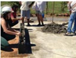
120 Passo: Fechamento da parte superior da forma lateral após aplicação de argamassa
