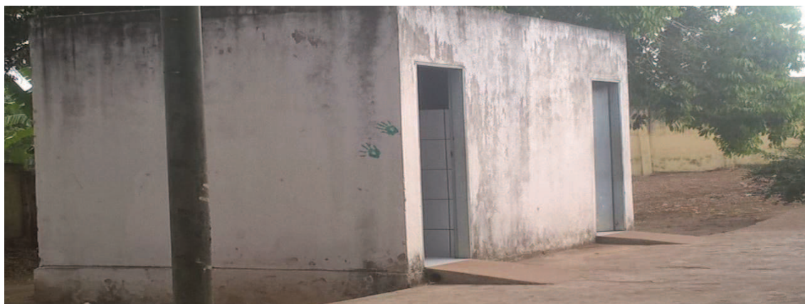
Foto 5 arquivo da escola, 16 de novembro de 2017 WC feminino e masculino da instituição.
