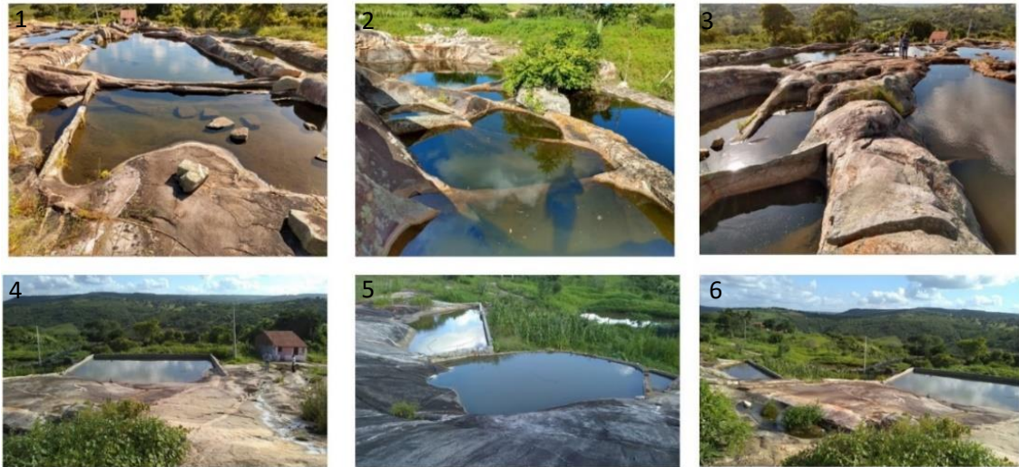
Box 1: tanque de pedra e aproveitamento de marmitas para armazenamento de água
