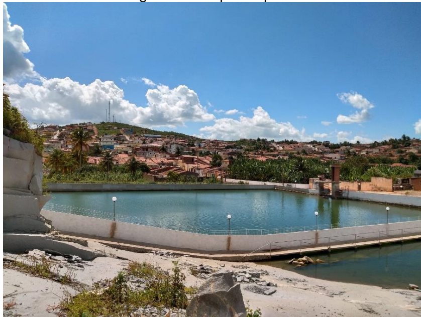
Figura 2: Tanque de pedra
