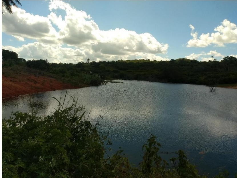
Figura 3: Barragem construída pela prefeitura na zona rural
