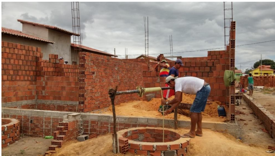
Figura 04 - Obra de retirada do material;
