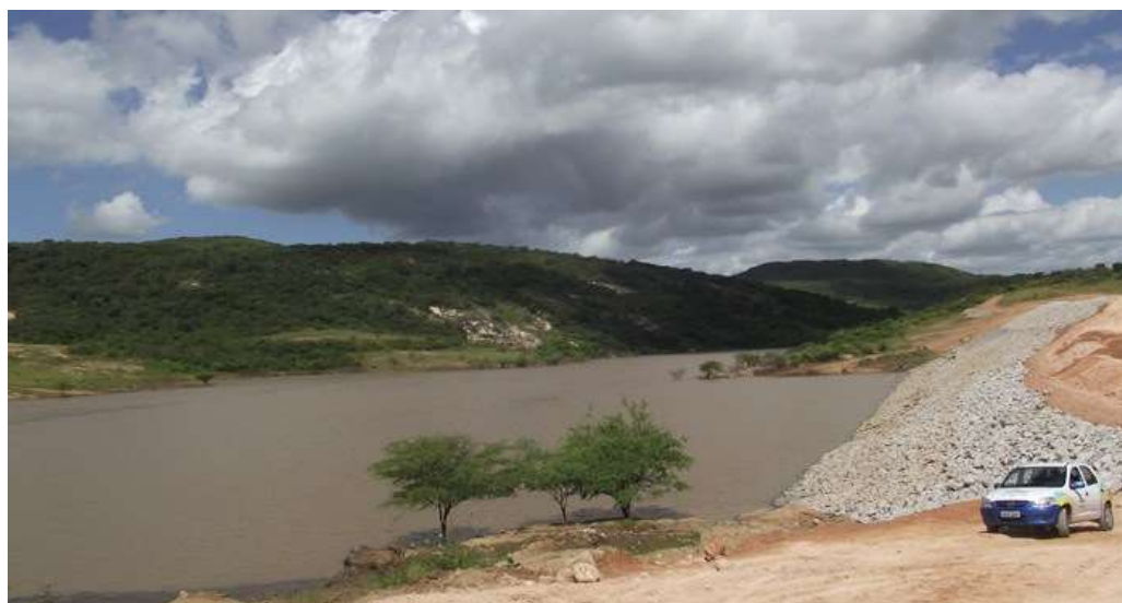
Figura 5 – Barragem de Jandaia
