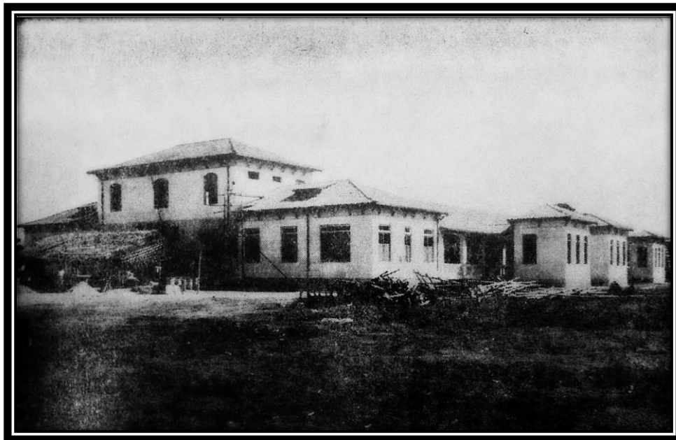
Imagem 1 – Hospital-Colônia Juliano Moreira em construção
