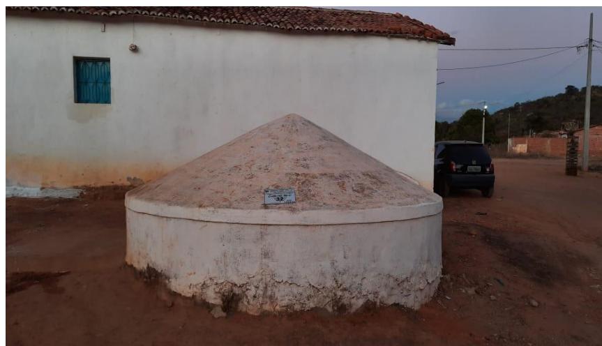
Figura 8 – Cisterna de placa para captação de água.
