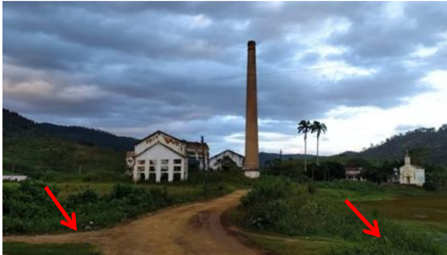
Figura 4. Aspecto das ruínas da Usina Tanques S/A, em Alagoa Grande/PB.
