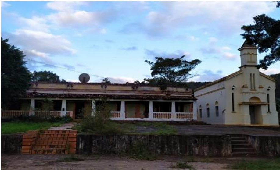
Figura 5. Aspectos da residência do proprietário da Usina Tanques S/A, em Alagoa Grande/PB.
