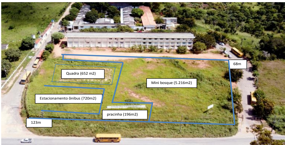
Figura 3. Parte frontal do CH/UEPB, com a divisão dos espaços para a construção do bosque.
