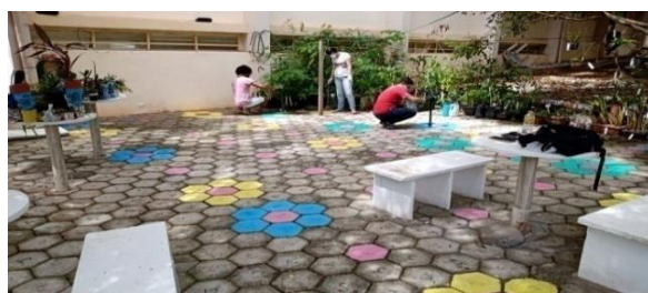
Figura 23. Pintura do piso da pracinha do viveiro do HBCB/CH/UEPB, 2021.
