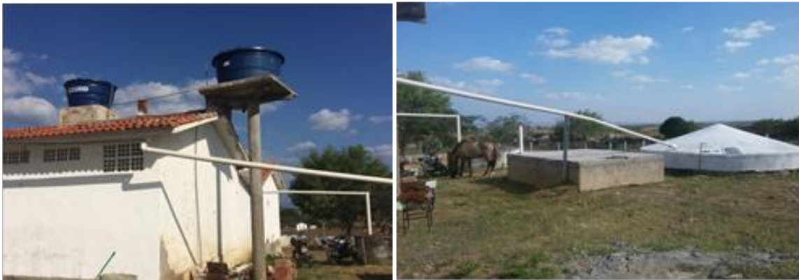
Figura 4 - Cisterna com sistema de captação de água da chuva na escola municipal de Queimadas - PB.
