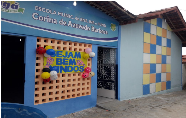
Figura 1 Escola Municipal Corina de Azevedo Fonte: Elidiane Santos
