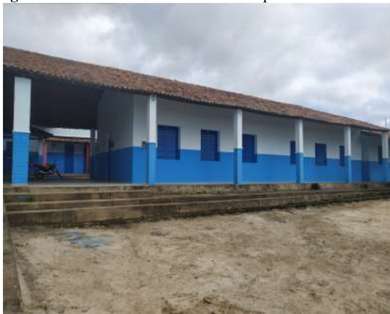
Figura 2 – Vista interna da Escola Municipal Machado de Assis
