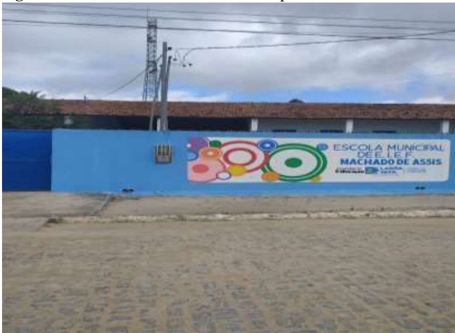
Figura 1 – Vista externa da Escola Municipal Machado de Assis
