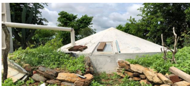
Figura 9 - Cisterna bem conservada
