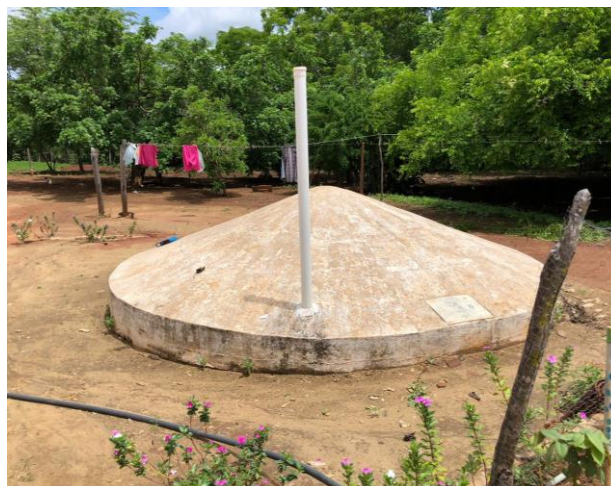
Figura - 8 Cisterna de Placa
