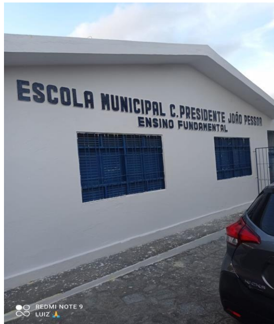
Figura 2 – Fachada da EMEFPJP
