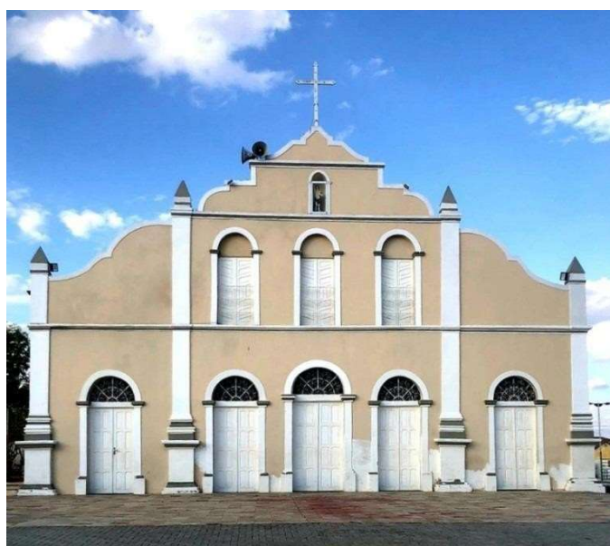
Figura 59. Igreja matriz da cidade de Gurjão dedicada a São Sebastião
