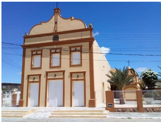
Figura 27. Igreja de São Sebastião, em Taperoá, copadroeiro do município
