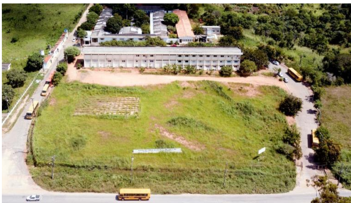
Figura 2: vista frontal da universidade (UEPB) antes das atividades
