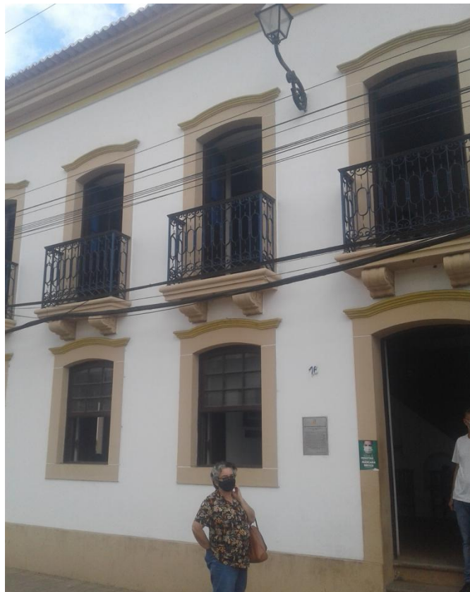
Detalhes da fachada do Solar José Rufino. Fonte: Acervo do Autor /2022.
