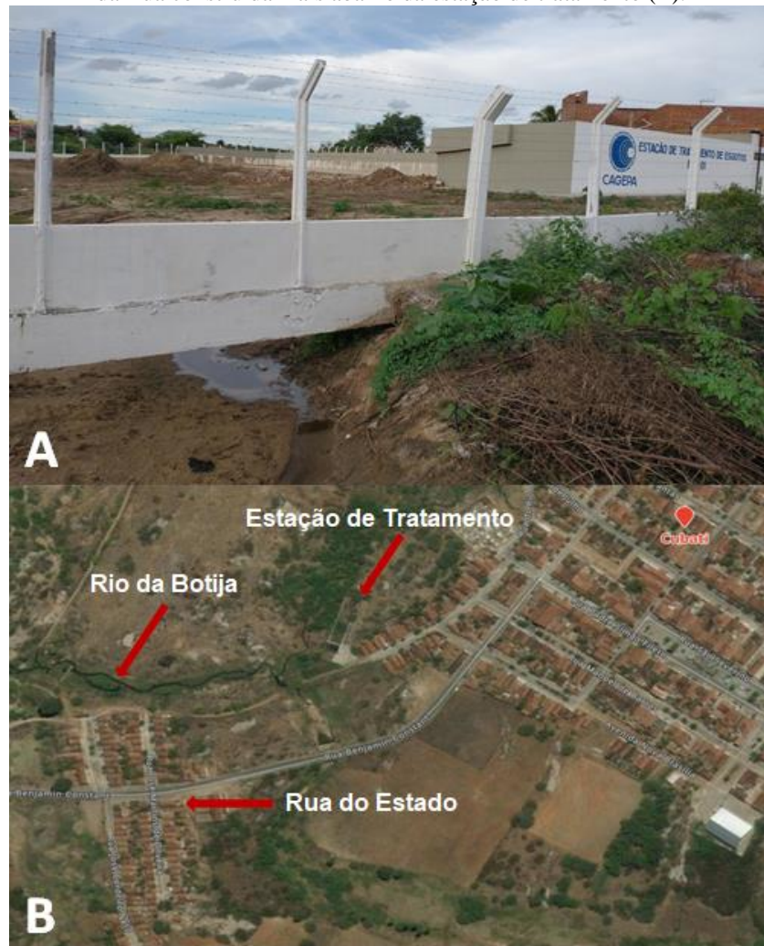
Figura 13: Estação de tratamento desativada (A); Localização da Estação de Tratamento Desativada, do Rio e da Rua construída mais abaixo da estação de tratamento (B).
