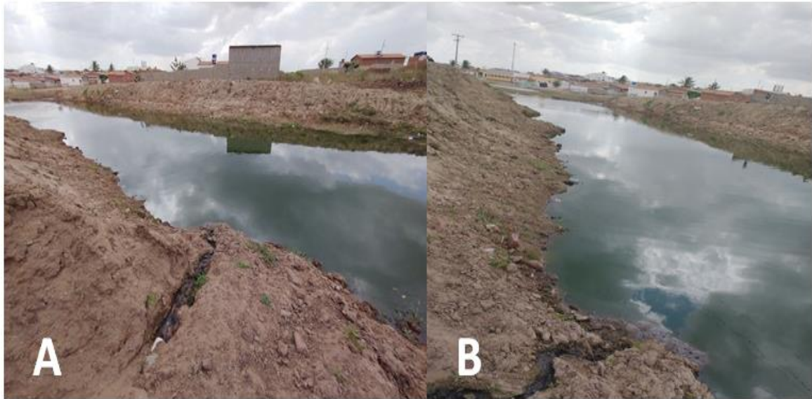
Figura 4: Acúmulo de esgoto no leito do rio. É possível observar encanamento direto para o leito (A); Leito do rio com grande quantidade de esgoto em visão longitudinal (B). Registro efetuado em Março de 2022.
