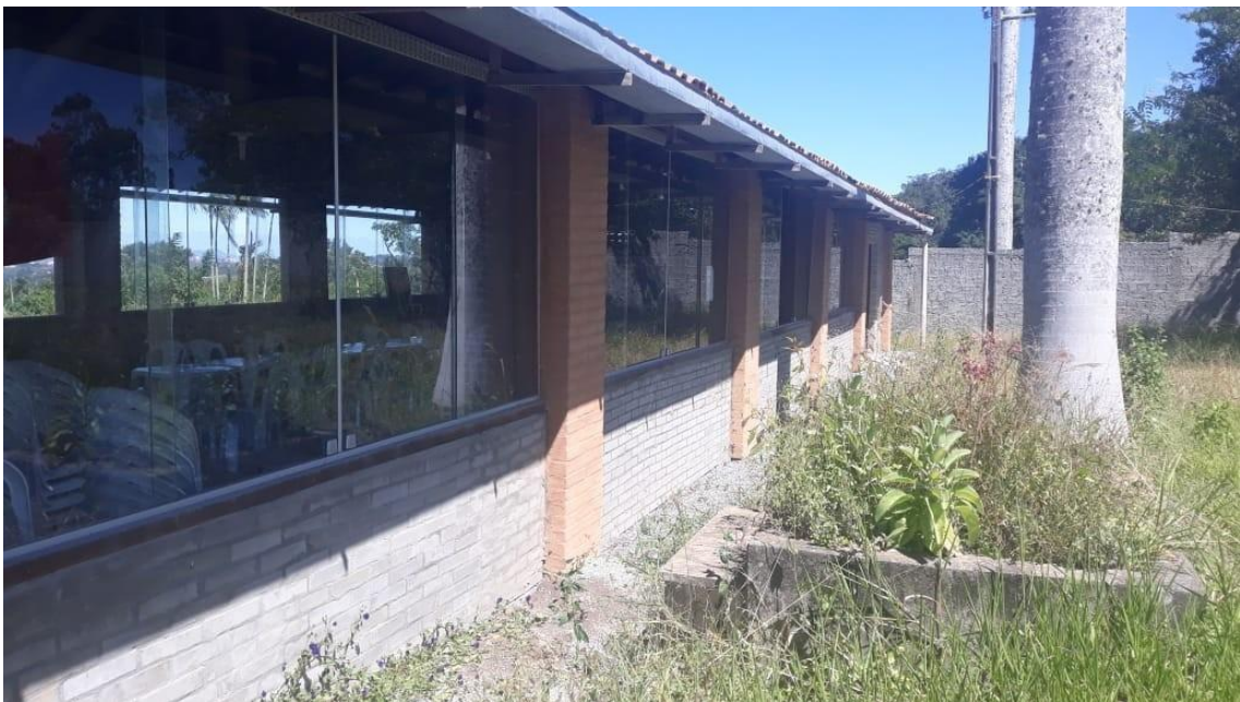
Figura 5.1: Vista lateral do Auditório Fidel Castro
