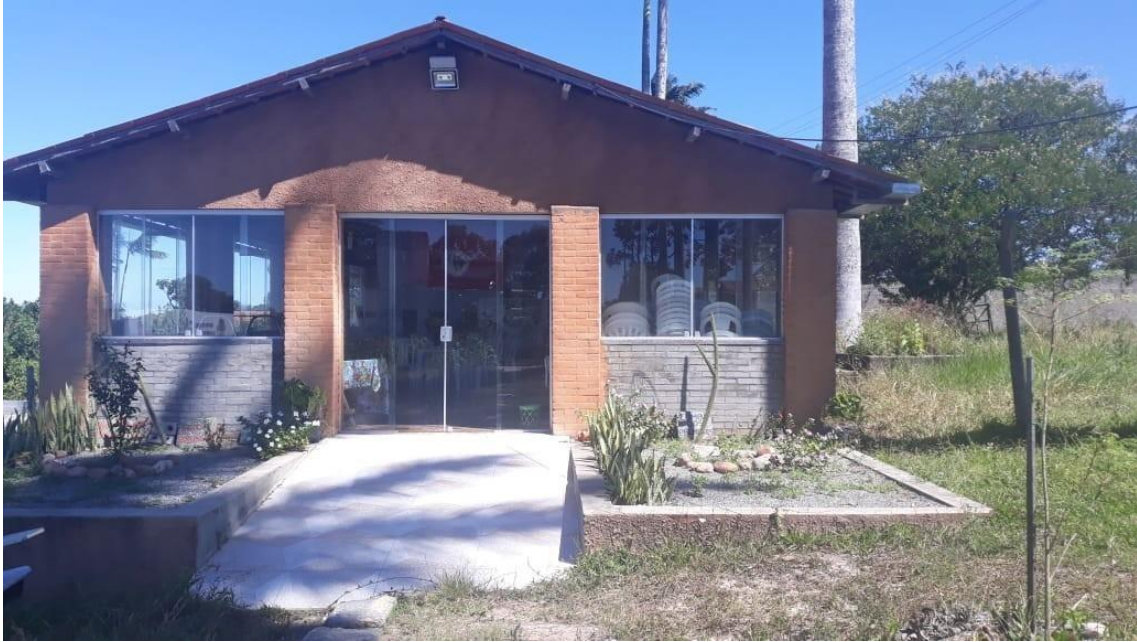
Figura 5: Vista frontal do Auditório Fidel Castro
