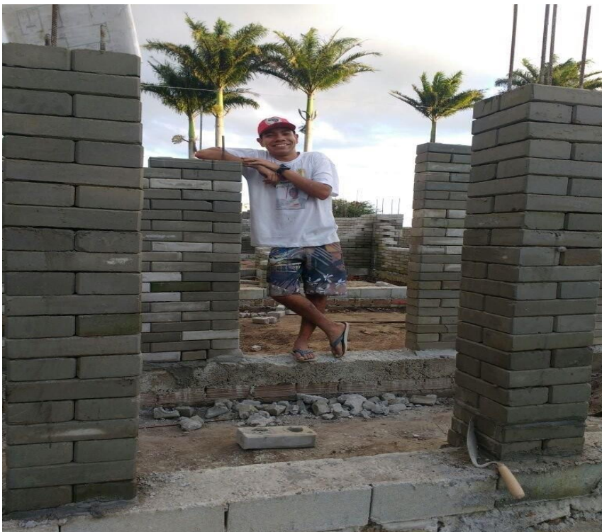
Figura 6.1: Construção da Cozinha do CFEJPT
