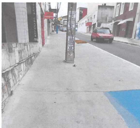
Figura 7: Reforma nas calçadas do centro de Campina Grande/PB, Rua Dr. João Tavares. Obs. Composição de sinalização tátil de alerta e direcional – Exemplo: mudanças de direção.
