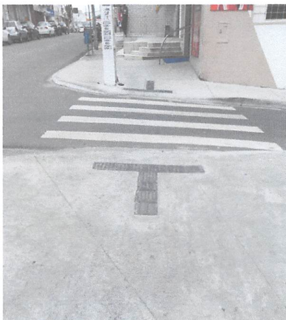
Figura 6: Reforma nas calçadas do centro de Campina Grande/PB, cruzamento entre a rua Afonso Campos x R. Dr. João Tavares. Obs. Composição de sinalização tátil de alerta e direcional – Exemplo: mudanças de direção.
