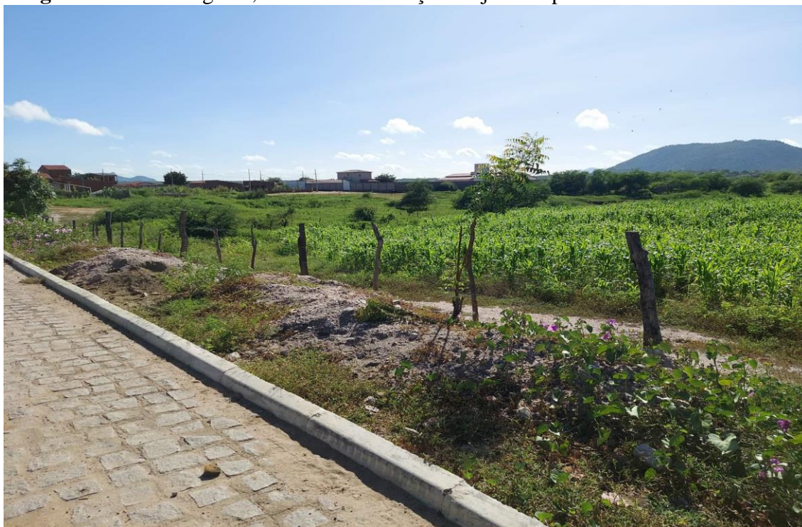
Figura 13: Área alagável, ao fundo construções sujeitas a problemas com enchentes.
