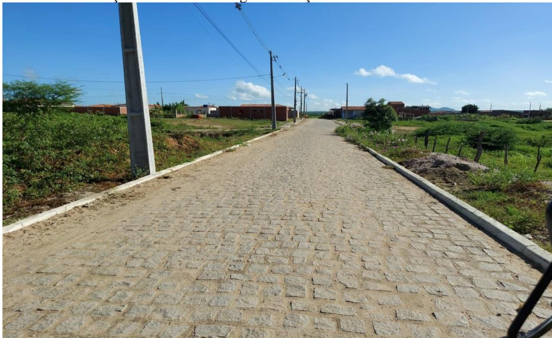
Figura 11: Intervenção do poder público municipal com construção de aterro e calçamento em área alagável do açúde Riacho dos Cavalos.
