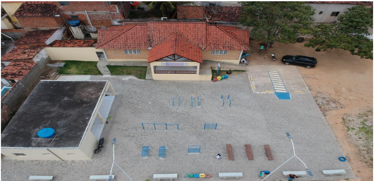
Figura 7 - Foto vista aérea da pracinha em Vila Maia – PB.
