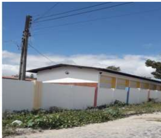
Figura 03 – Fachada Lateral da Escola
