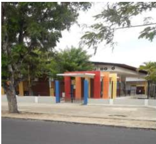
Figura 02 – Fachada Principal da Escola
