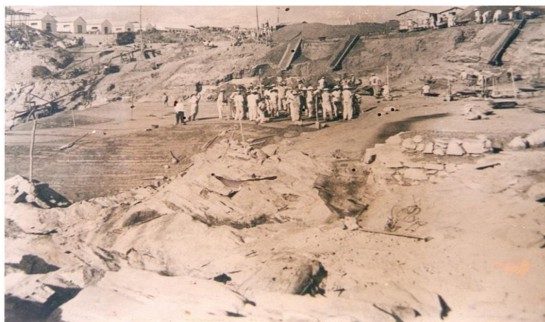
Figura 4 – Trabalhos de fundação
