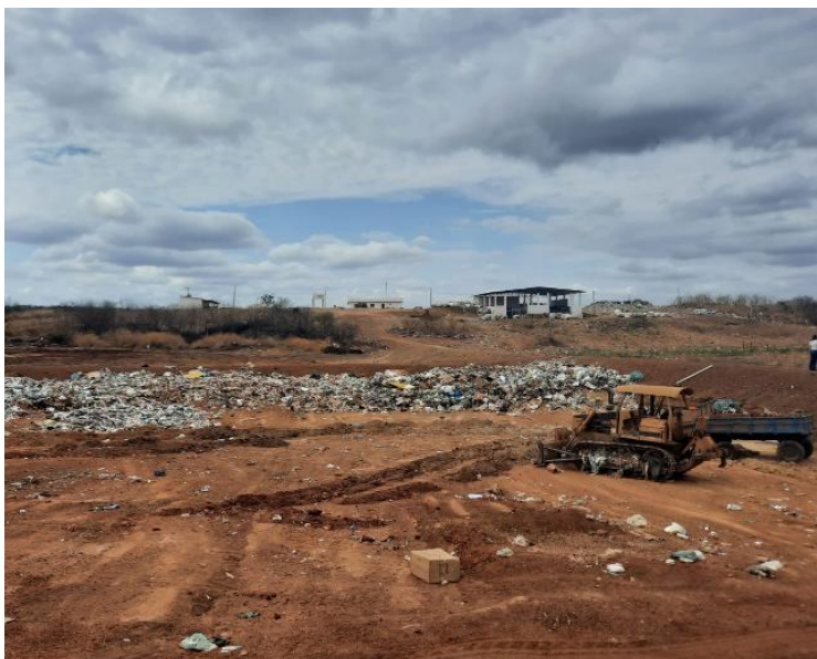
Figura 3- Aterro sanitário de Coremas-PB.
