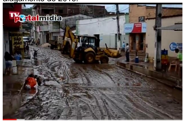
Figura 20 - Retroescavadeira fazendo limpeza das ruas do centro de Alagoíinha/PB após o alagamento de 2016.
