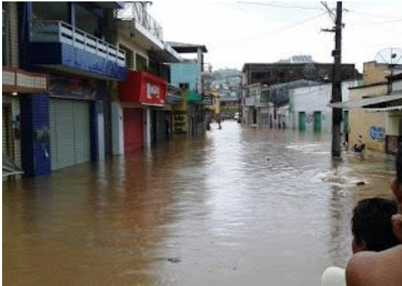
Figura 17 - Alagamento no centro de Alagoíinha em 2016.
