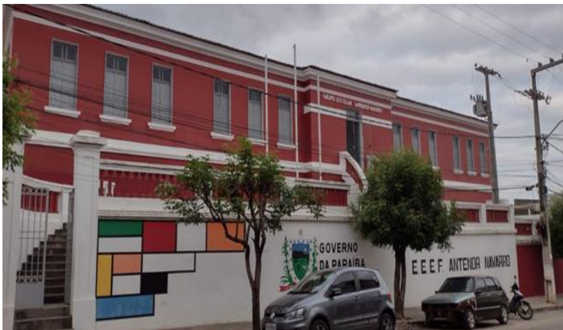
Figura 1 – Fachada da EEEF Antenor Navarro, escola-campo instalada na zona urbana da cidade de Guarabira/PB.
