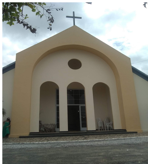
Foto 2 - Igreja N.S do Carmo na Fazenda do Sol
