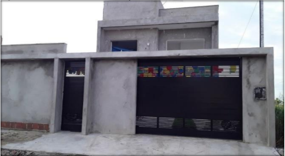
Figura 10: Residência em fase de construção
