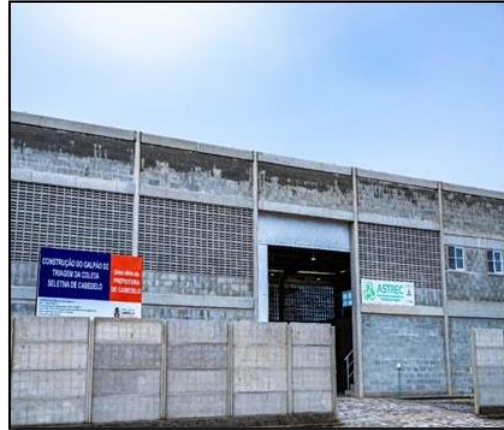
Foto 2. Galpão de triagem (parte externa)
