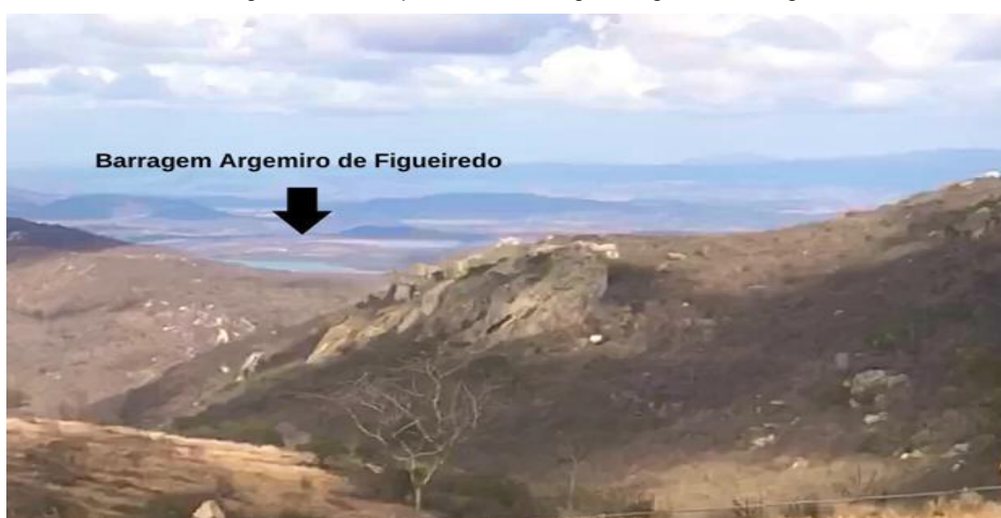
Figura 22: Vista parcial da Barragem Argemiro de Figueiredo
