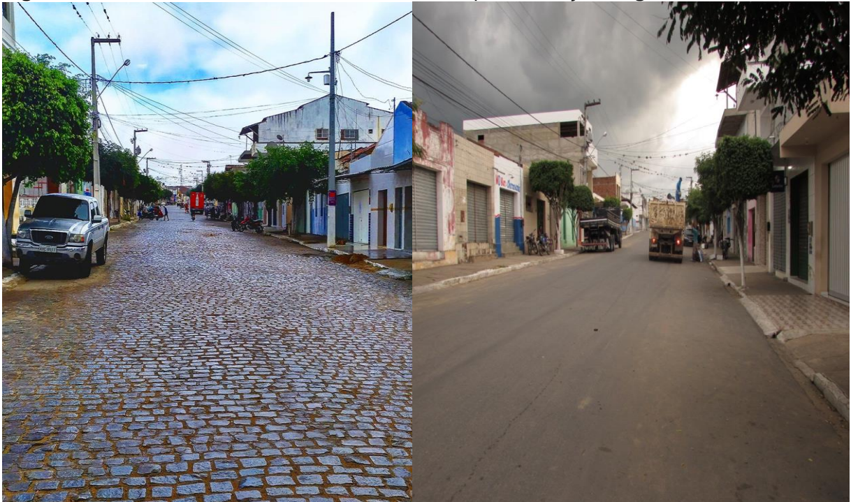
Figura 4: Centro da cidade de Gado Bravo, sem pavimentação. Figura 5: Rua asfaltada.
