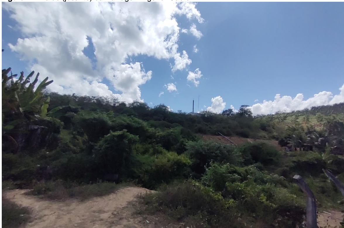
Figura 4 – Balde (jusante) da Barragem Agenor Cabral.
