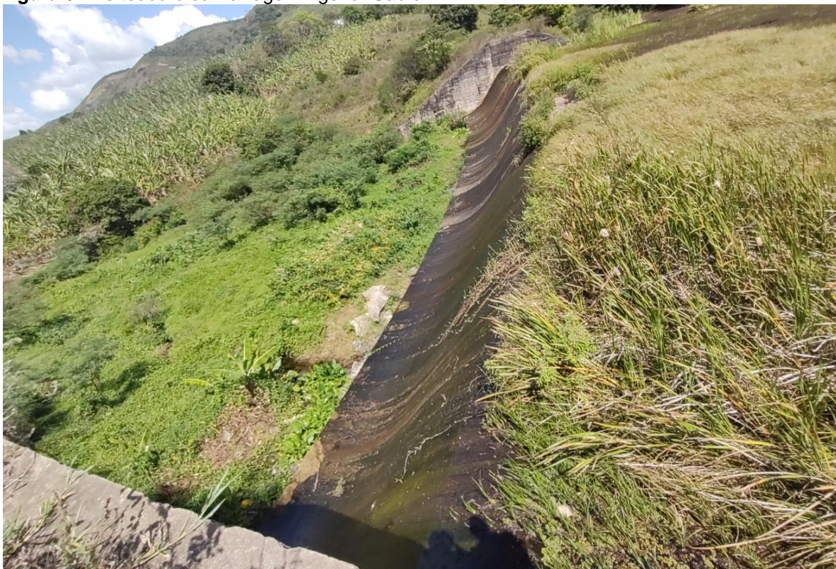
Figura 6 - Vertedouro da Barragem Agenor Cabral.
