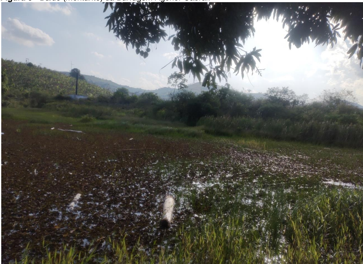
Figura 5 - Balde (montante) da Barragem Agenor Cabral.
