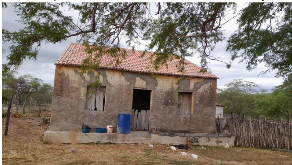
Figura 1: Casa onde era localizada a escola Sítio Sossego
