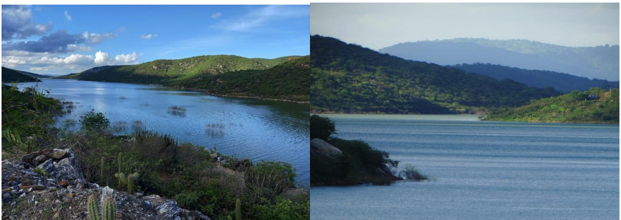
Figura 26: Barragem de Acauã município de Aroeiras
