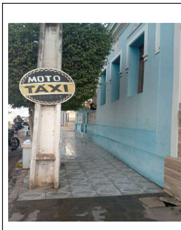
Foto 1 - Ponto dos Mototaxistas sem cobertura
