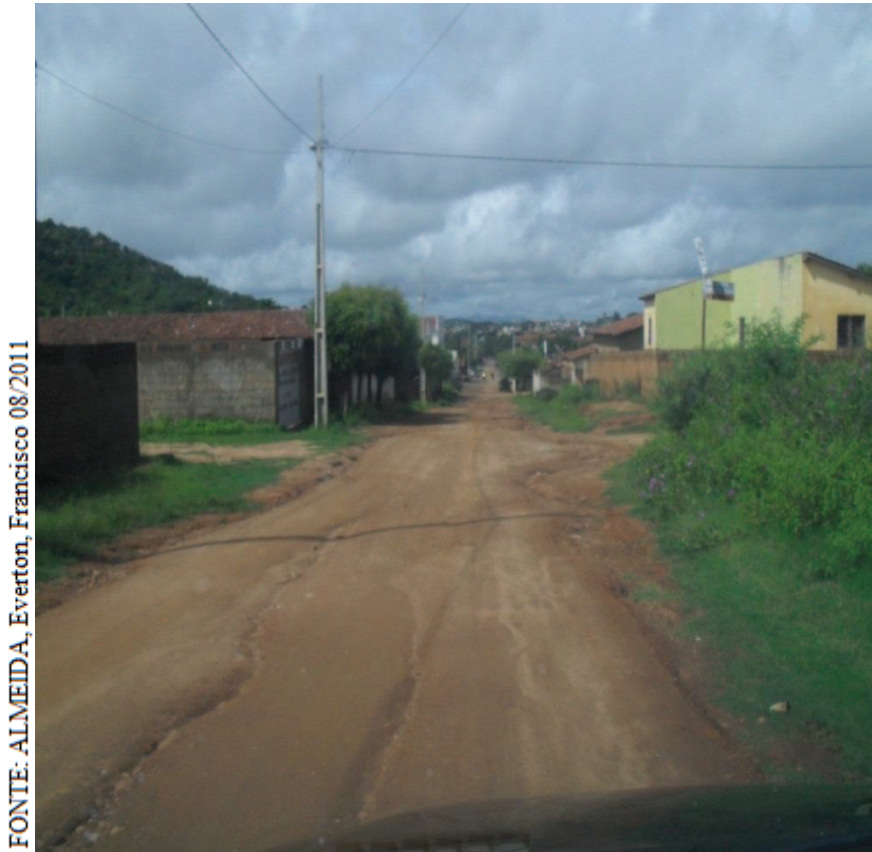
FIGURA 05: Rua sem pavimentação localizada no bairro da Rocinha.
