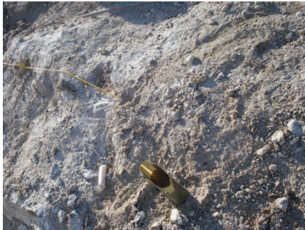
Figura 23: Preparação para detonação Fonte: Pesquisa de campo (2011).
