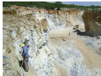
Figura 43: Trabalhador furando rocha de calcário para preparar detonação 2.
