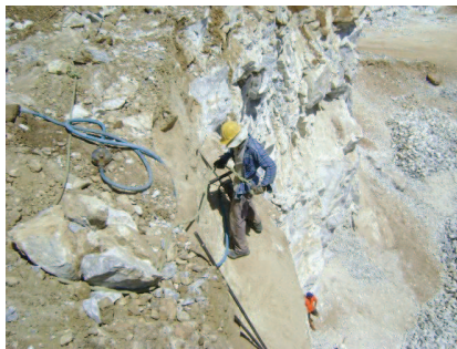
Figura 42: Trabalhador furando rocha de calcário preparar detonação 1.
