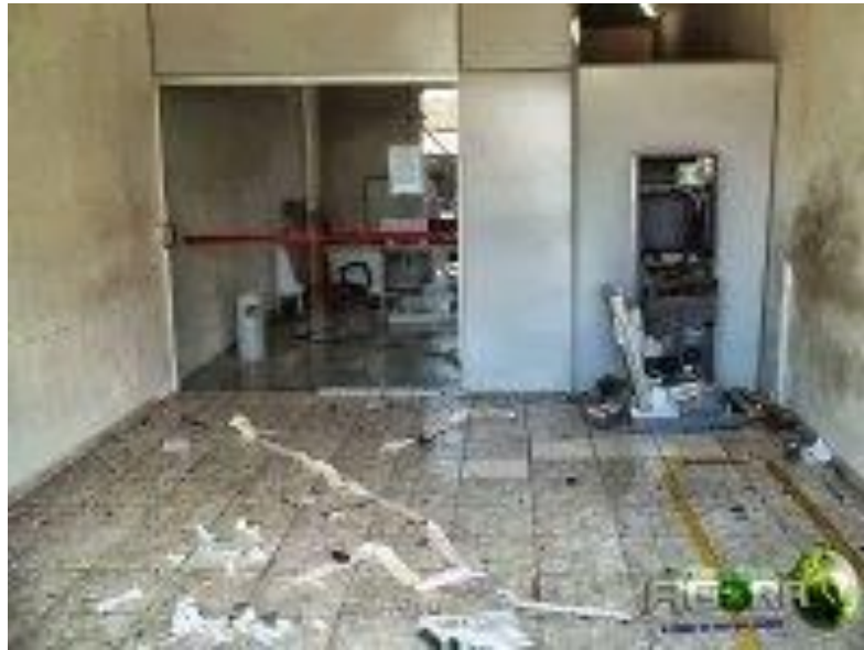
Figura 1. Agência do Bradesco de Gurjão – PB após explosão.
