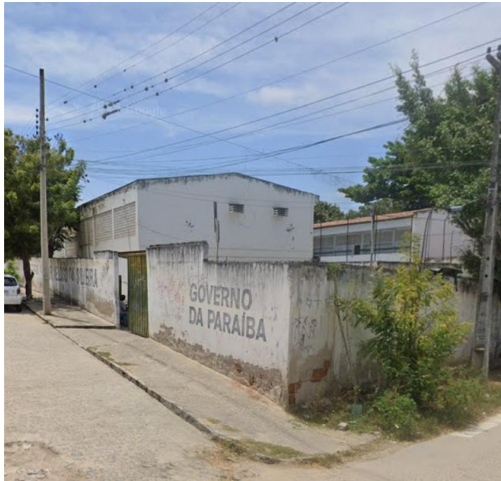
Figura 1: Fachada da EEEFM Ademar Veloso da Silveira
