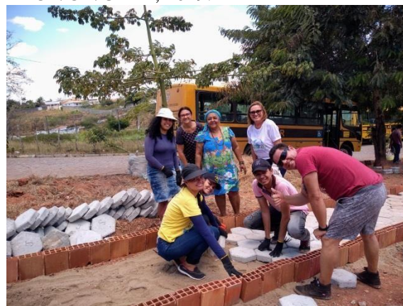
Figura 4: Parte da equipe realizando a construção da pista principal de caminhada do HBCB/CH/UEPB, 2019.
