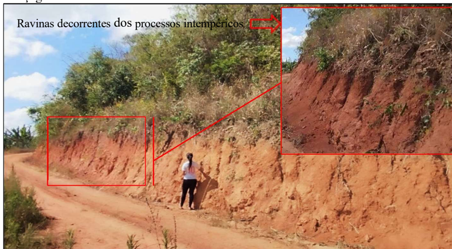
Figura 32: Corte do relevo para construção de estrada na Serra de São Vicente, Araçagi/PB.
