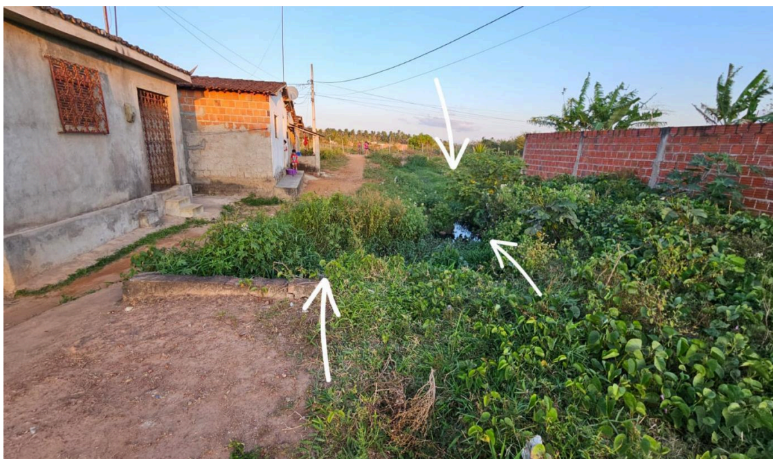
Imagem 6- Moradores mais expostos ao esgoto a céu aberto
