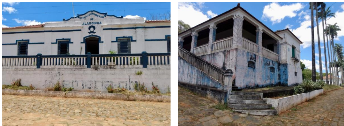
Figura 7 - Casarão C4 fachada, lateral e entrada do casarão C5
