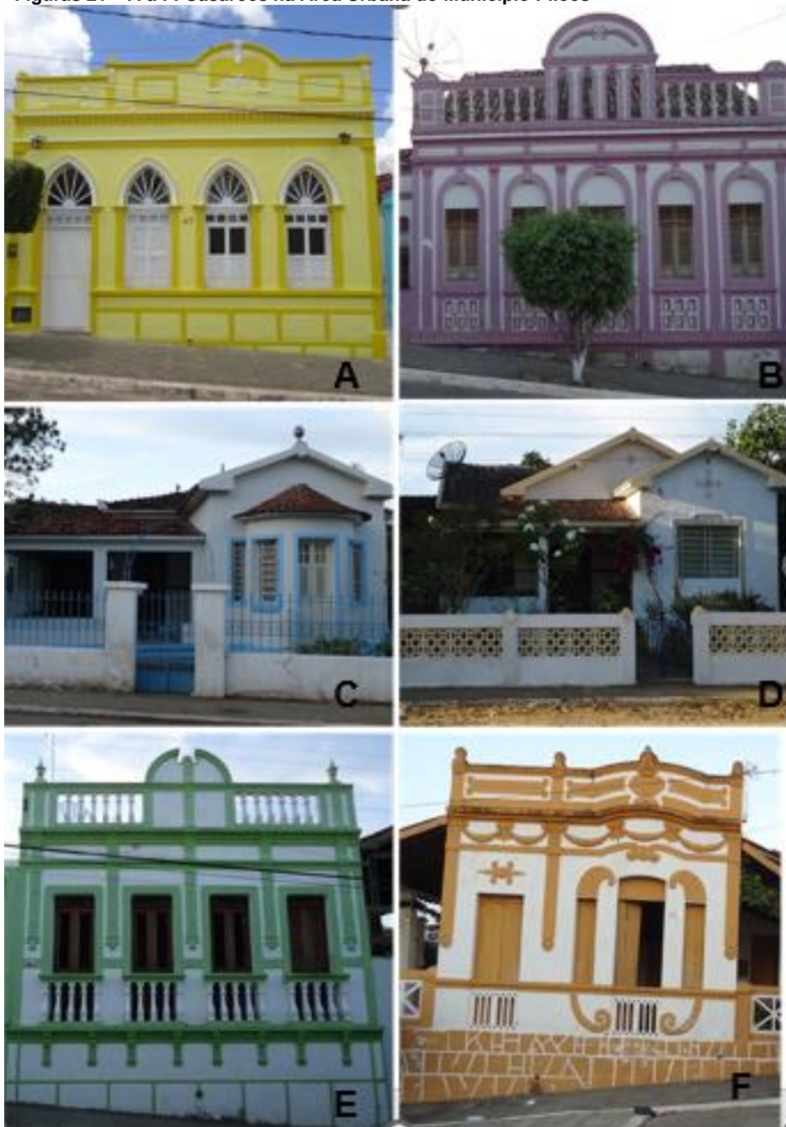
Figuras 21 – A à F: Casarões na Área Urbana do Município Pilões
